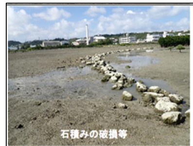
図-7 新港地区試験造成地の機能低下の例
