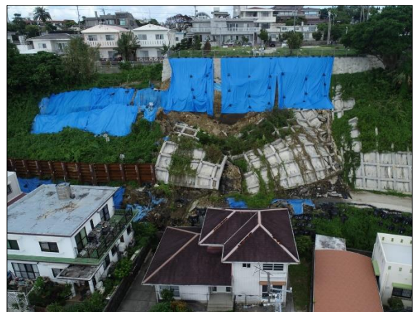
図 1.2 既設法枠を含む斜面崩壊状況 (R2.9)
