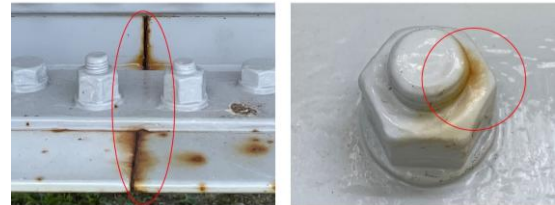
写真 1-1 鋼橋の腐食損傷の例
